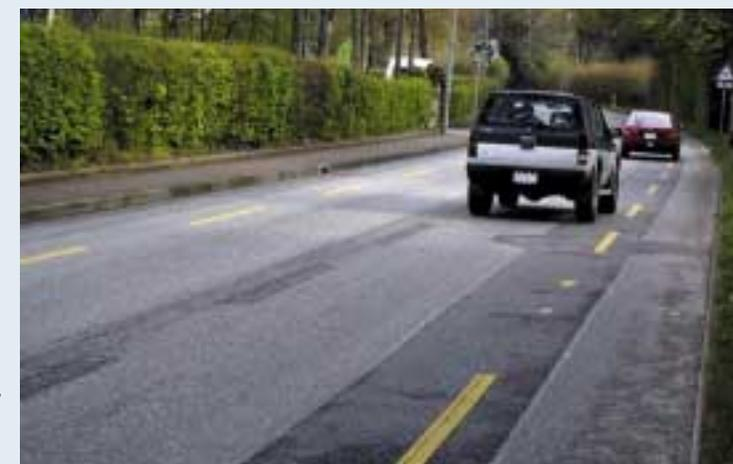
*Double bande polyvalente sur une chaussée de 7 mètres de large. A noter que la bande médiane a été effacée.*
